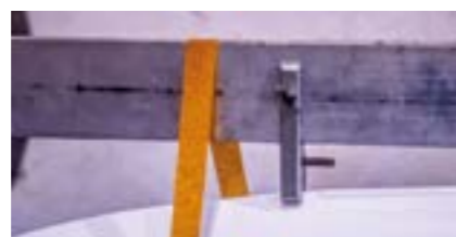
Установка продольного бруса на станции 8
